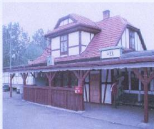
Stacja kolejowa HEL
